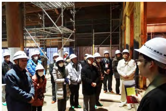
第15組推進員による別院御修復現場視察の様相
