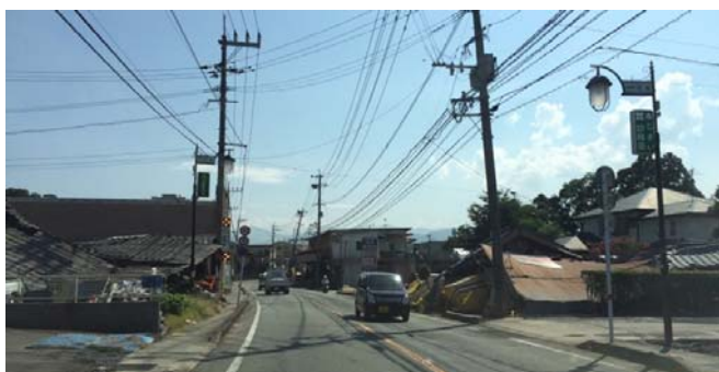
手つかずの倒壊建物(益城町)
